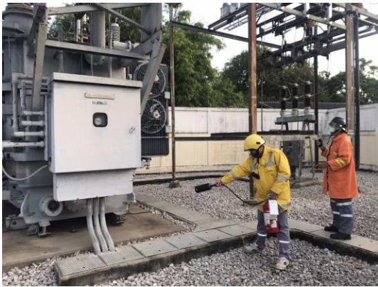
7. ทีมฉุกเฉินเข้าสู่ที่เกิดเหตุและทำการฉีด CO2 เพื่อดับเพลิงที่ Control Panel หม้อแปลง
